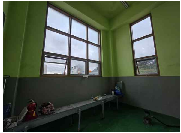
검수실 내부 전경
