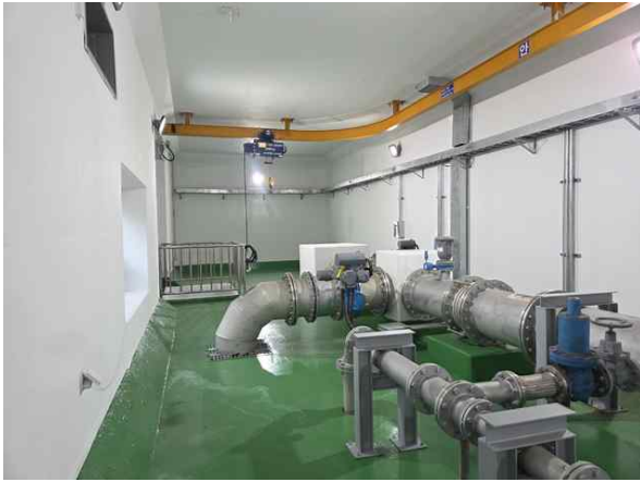
유입밸브실 내부 전경
