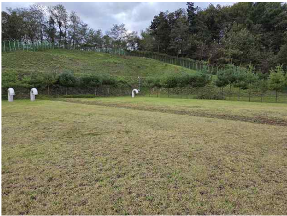
배수지 상부 현황
