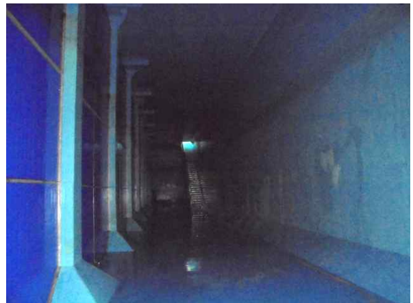
배수지 2지 내부 전경
